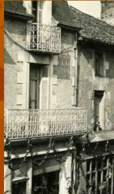
Un balcon typique « maître d'œuvre M. GOUDEAU »
